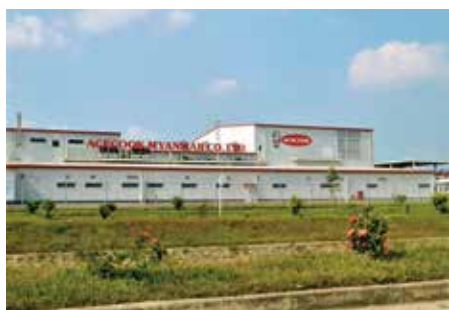
ベトナムに続きミャンマーに進出したエースコックもクーデター後に一時工場を止めた（ティラワ工業団地）
