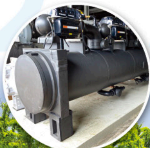
高効率冷凍機による熱供給
